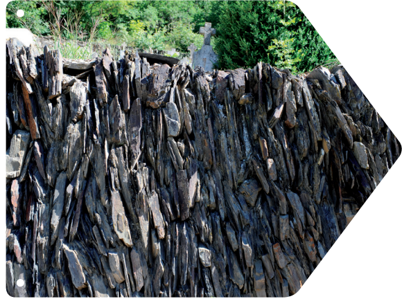
Muret en pierres clavées.
