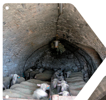
Arcs en pierre et charpente en bois.
